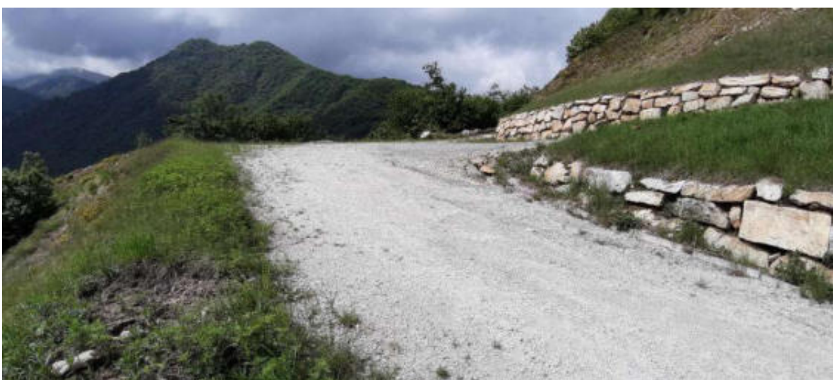
Scogliere in massi per il contenimento delle scarpate dei tratti di pista sistemati nel 2018 con riprofilatura e sostituzione della pavimentazione in tout-venant (maggio 2020)
