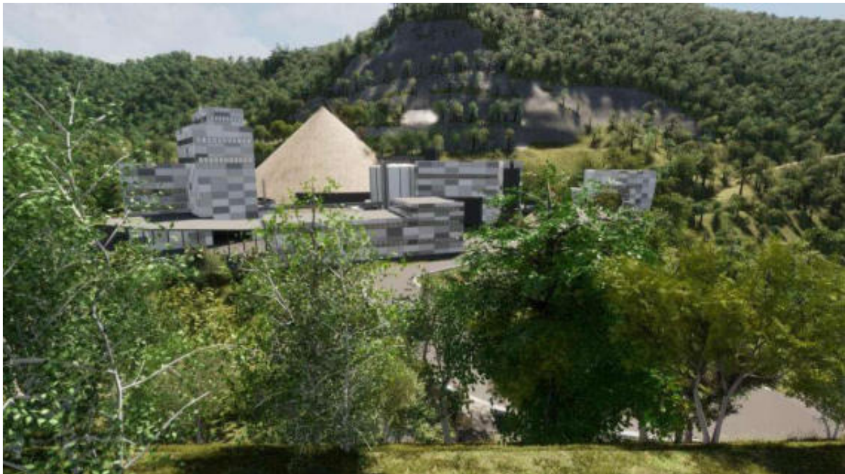
Vista dell'impianto di trattamento del minerale estratto dalla SP237 in prossimità della strada di accesso alla cava
