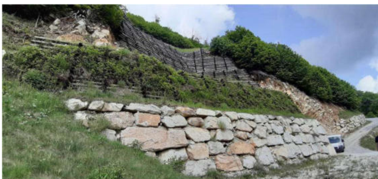
Viste del muro cellulare ad elementi in legno con pedate ricoperte in terra e inerbite posto tra le quote 990 e 1.015 al disopra del fronte centrale oggetto di recupero (maggio 2020)
