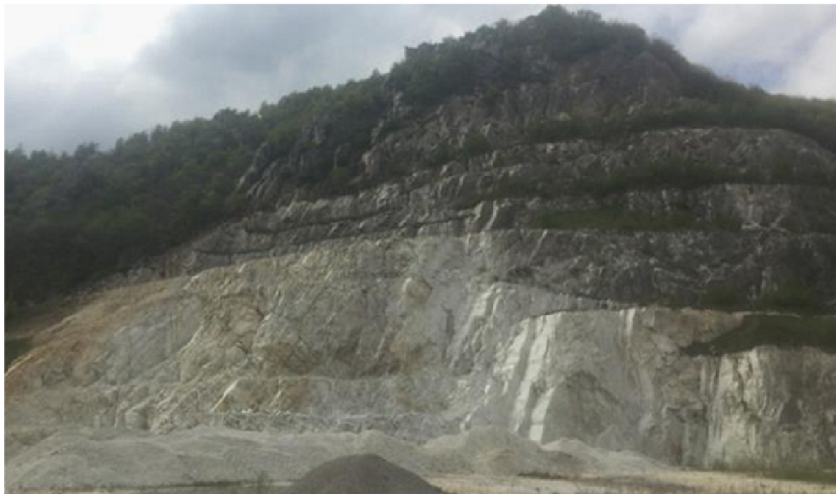
Lavori di arretramento e riprofilatura del fronte nell'area in cui il progetto prevede la realizzazione della galleria d'estrazione a valle del pozzo di gettito
